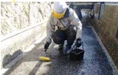
道路冠水対策工事
