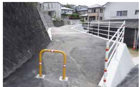
歩道設置工事
