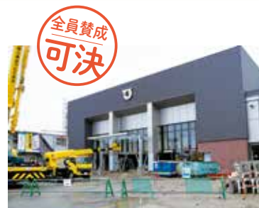
完成間近の町民センター
