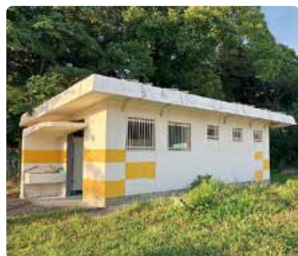
志免中学校屋外トイレ
