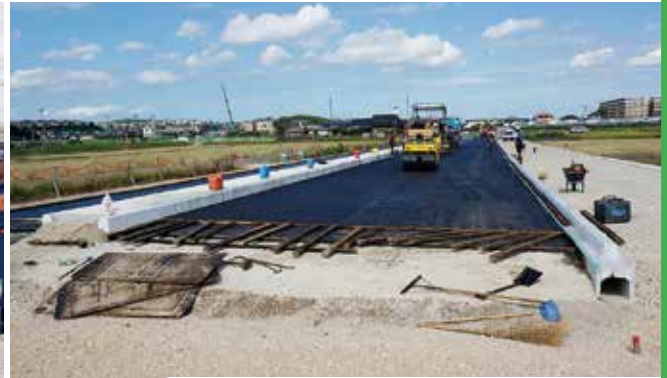
順調に整備が進んでいる志免・宇美線(吉原地区)
