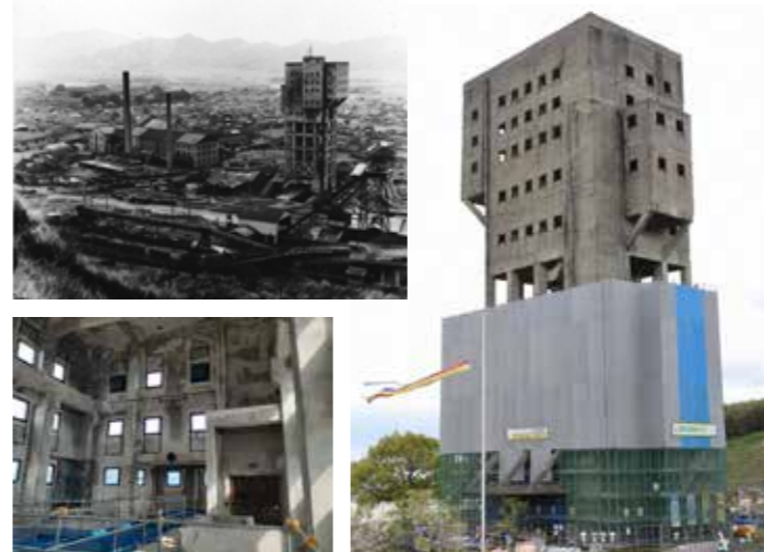
旧志免鉱業所 (左上) と保存修理工事中の堅坑槽 (左下・右)
