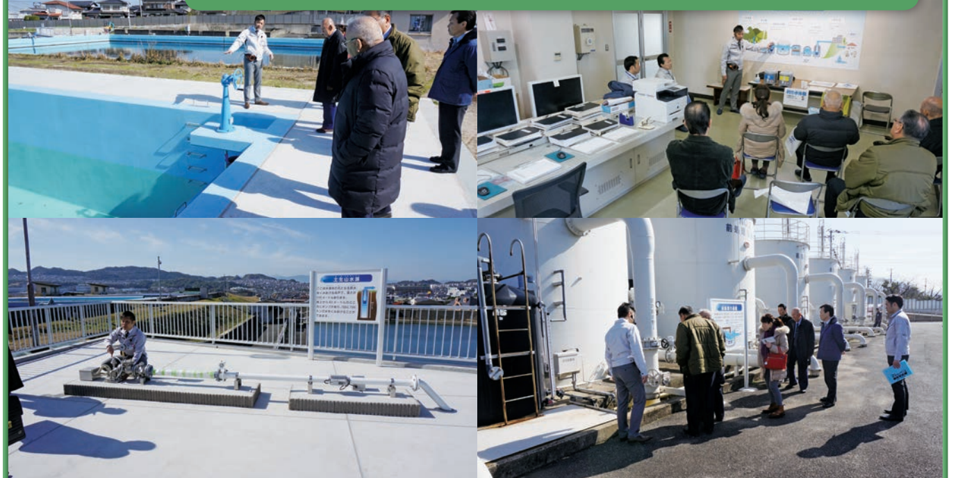
土生山浄水場視察
