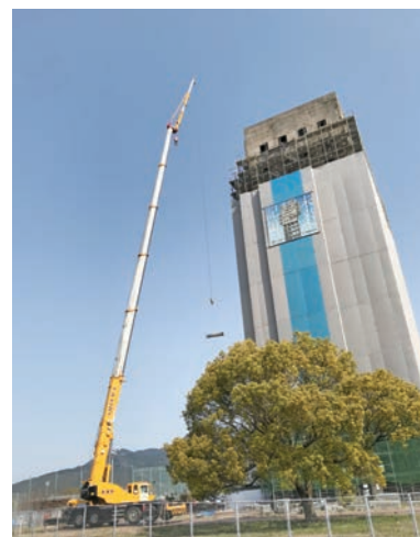
令和3年10月修理完了予定
