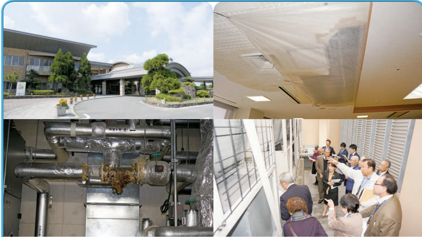
シーメイト視察(水漏れや空調の現状)
