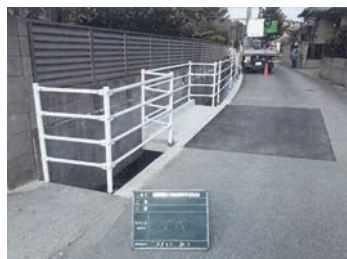
転落防止工事
