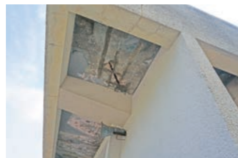
むき出しとなった鉄筋
