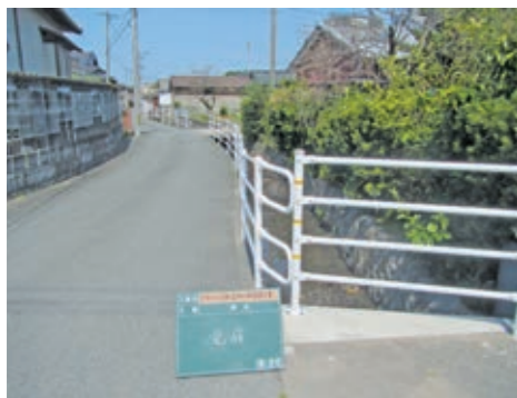
道路転落防止の対策工事
