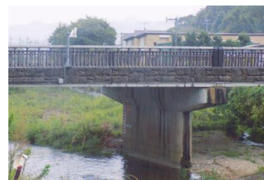
堆積土とライブカメラ(片峰新橋)
