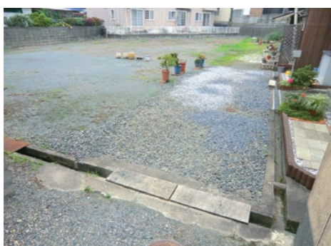
空き家の解体後
