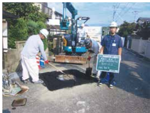
マンホールふた交換工事
