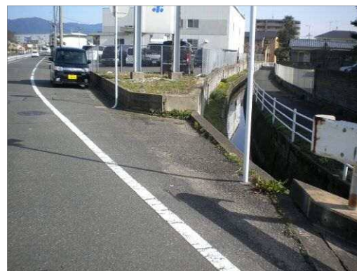
道路端部に柵がない
