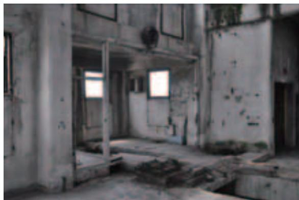
写真 4.1 堅坑櫓 8階に残された木床 周囲に延焼の危険性のある仕上げ等はみられない
