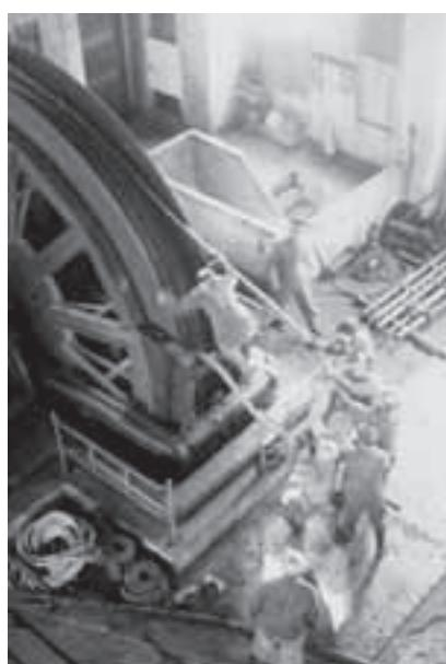
写真 14 卷上機のブーリーへのワイヤーロープの取り付け作業
