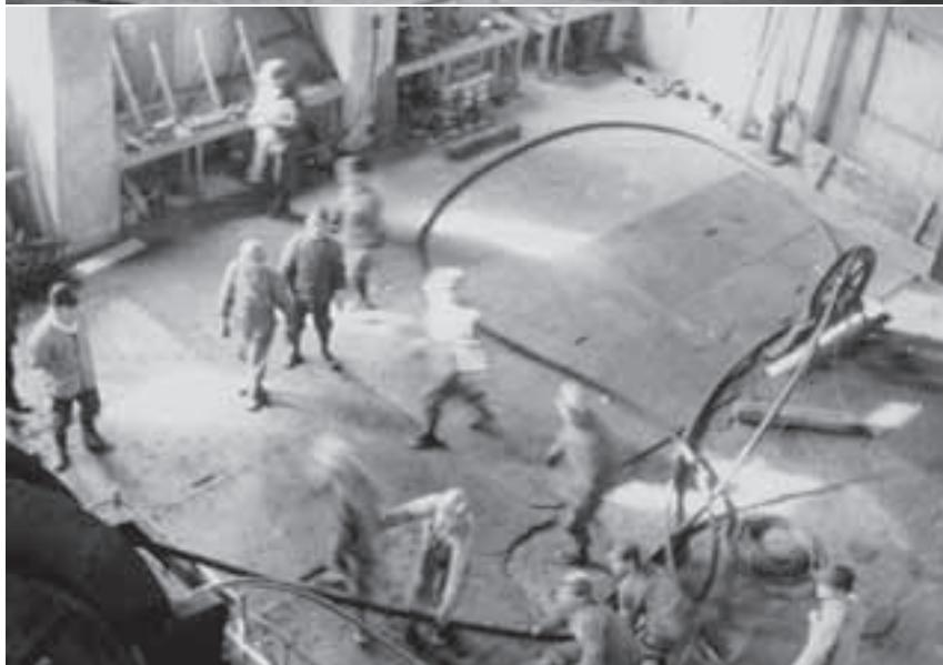
写真 12 卷上機ブーリーへのワイヤーロープ取り付け作業の様子、床面に鋼板が張られている
