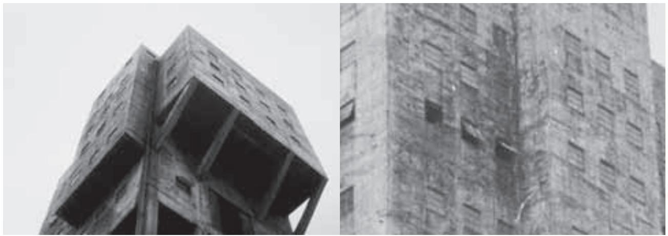
写真4 旧志免鉱業所堅坑櫓を見上げる（昭和40年代） 写真5 堅坑櫓の外壁、灯火管制用の窓が見える
