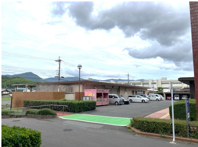
資材倉庫・犬舎(北西側)
