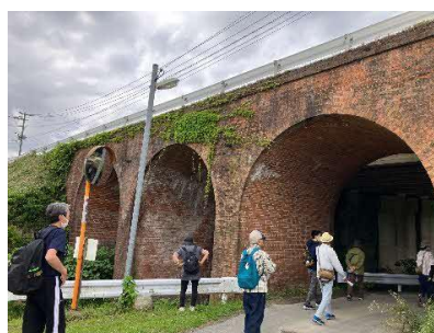
▲旧九州鉄道城山三連橋梁を見学
