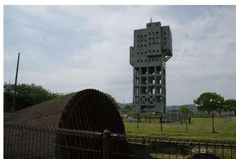
▲旧志免鉱業所 第八坑連卸坑口
