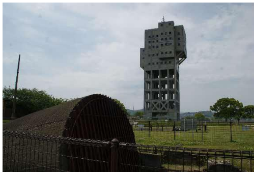
▲旧志免鉱業所 第八坑連卸坑口
