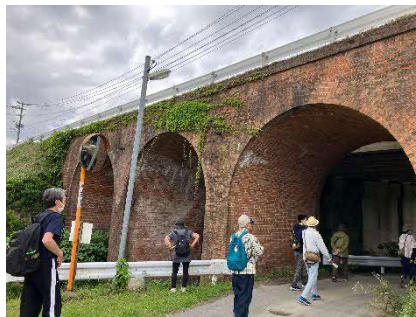
▲旧九州鉄道城山三連橋梁を見学
