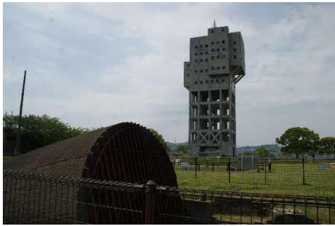
▲旧志免鉱業所 第八坑連卸坑口
