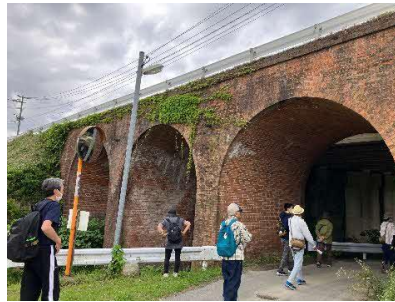
▲旧九州鉄道城山三連橋梁を見学
