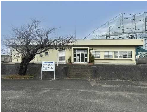
土生山浄水場
