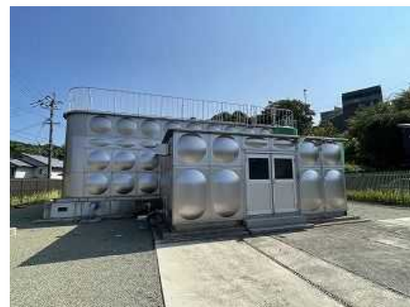
桜丘中区配水池
