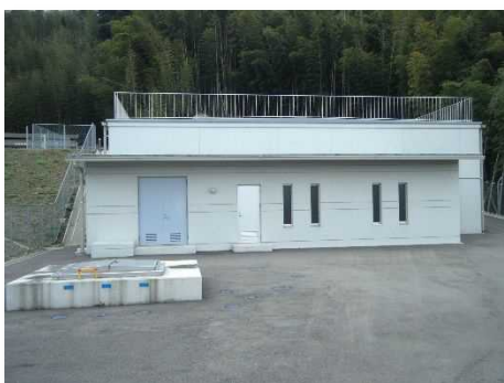
桜丘低区配水池
