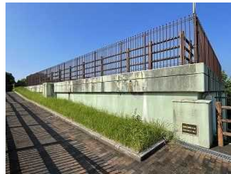
総合公園配水池
