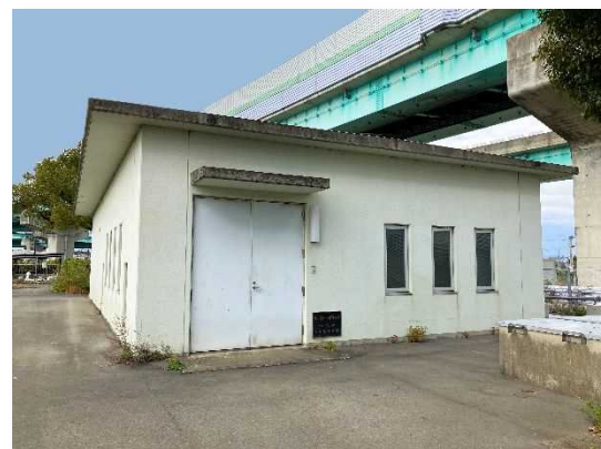
導水ポンプ室
