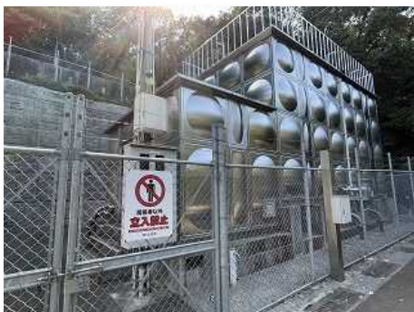
桜丘高区配水池
