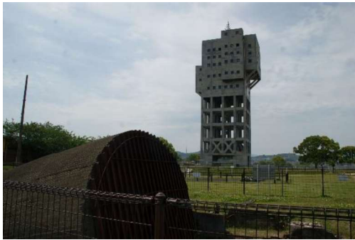
▲旧志免鉱業所 第八坑連卸坑口
