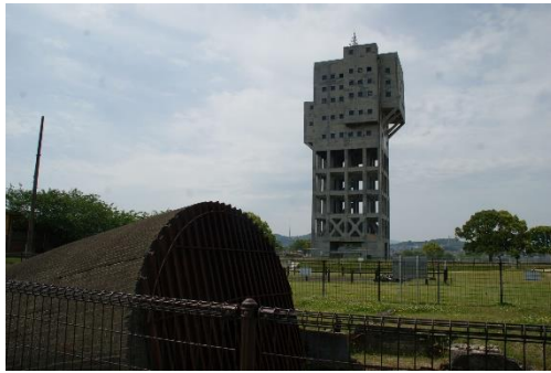
▲旧志免鉱業所 第八坑連卸坑口
