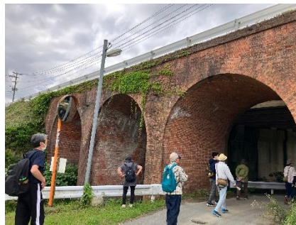
▲旧九州鉄道城山三連橋梁を見学
