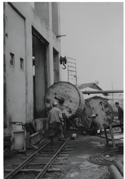
写真 15 同左、巻上機のためのワイヤーロープを豎坑槽西面より槽内に搬入している。
