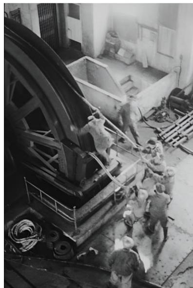
写真 14 巻上機のプーリーへのワイヤーロープの取り付け作業
