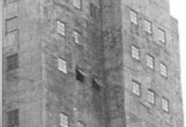
写真 5 竪坑櫓の外壁、灯火管制用の窓が見える。現在は残っていないが、突き出し窓であったことが確認できる。
