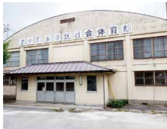
▲未耐震の志免東地区体育館
