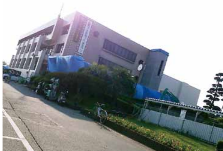
▲熊本地震で被災した庁舎
