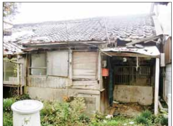
▲とりに倒れかけている危険廃屋
