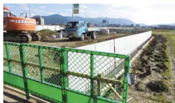
中部消防署西出張所 建設現場
