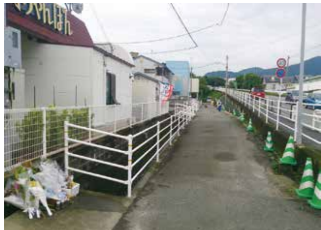
取り付けられた防護柵
