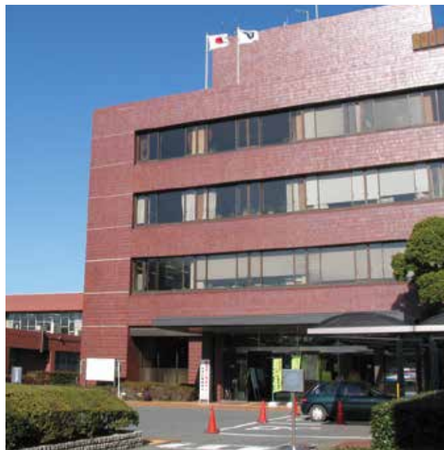
57年に建てた庁舎
