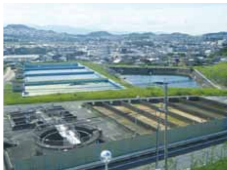
土生山浄水場(田富地区)
