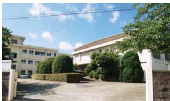
西小学校体育館と駐車場
