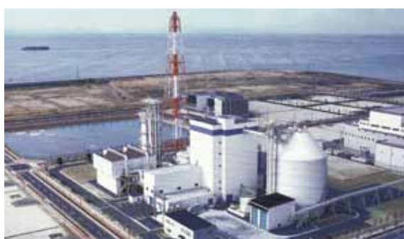
大牟田RDF発電所
