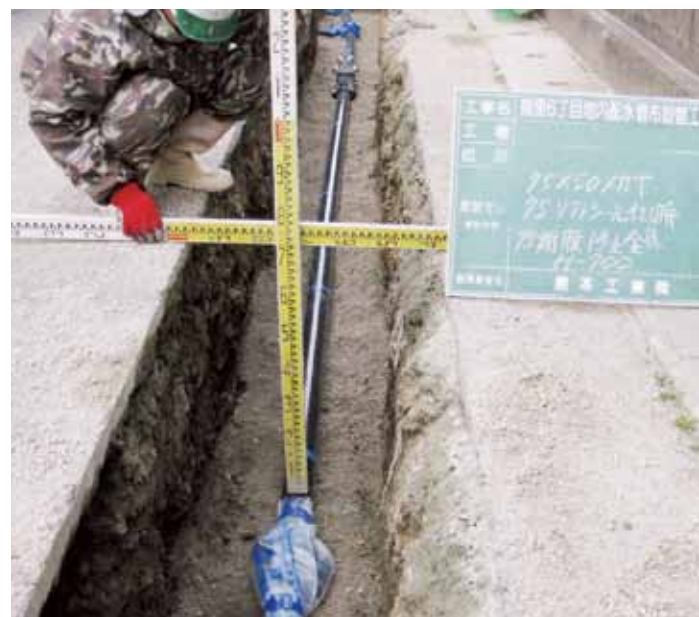
水道管の設置工事
