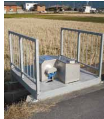
吉原・深町地内水門補修工事
