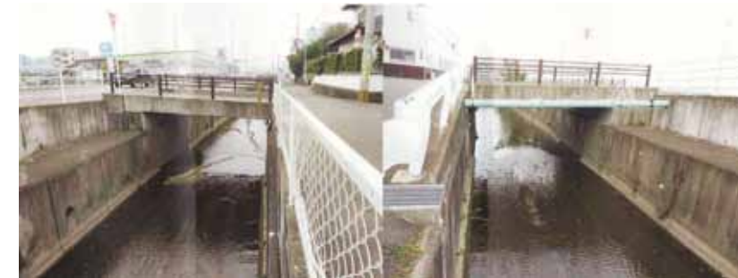
調査される橋梁
