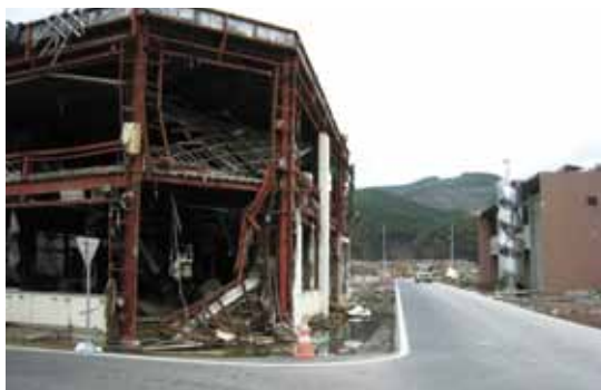
宮城県女川町被災状況
