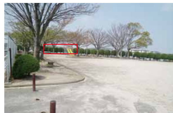
◀ 石橋台公園内に新設 (赤線の部分)
