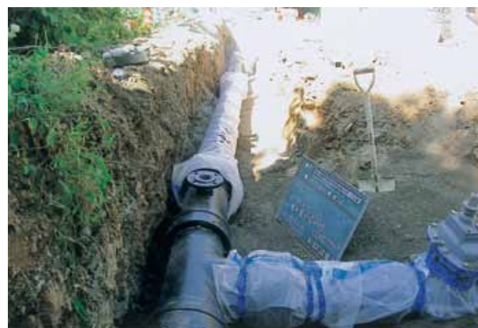
▲铸铁管NS使用の工事現場
