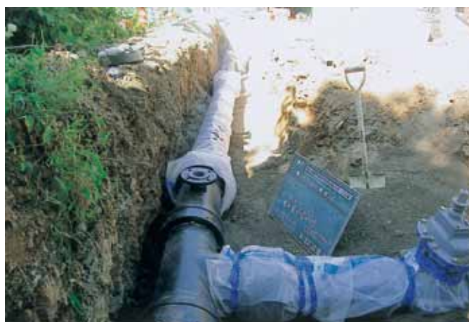
▲铸铁管NS使用の工事現場
