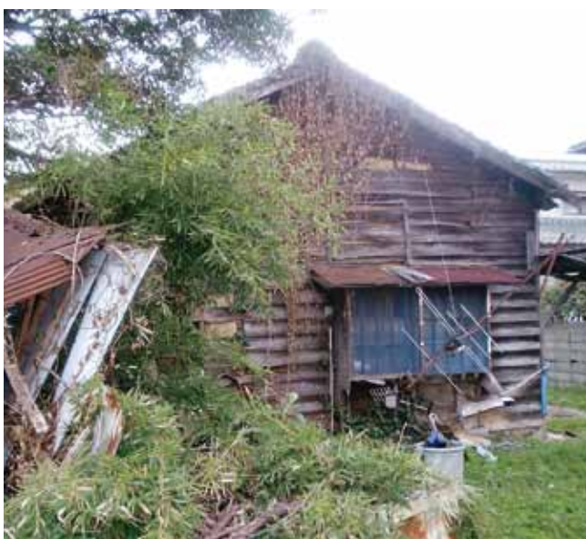
▲危険廃屋の解体支援を
