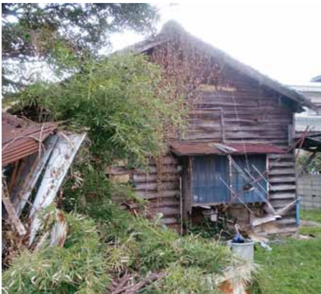
▲危険廃屋の解体支援を
