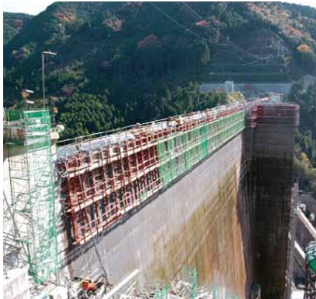
▲大山ダム工事の状況(日田市)
