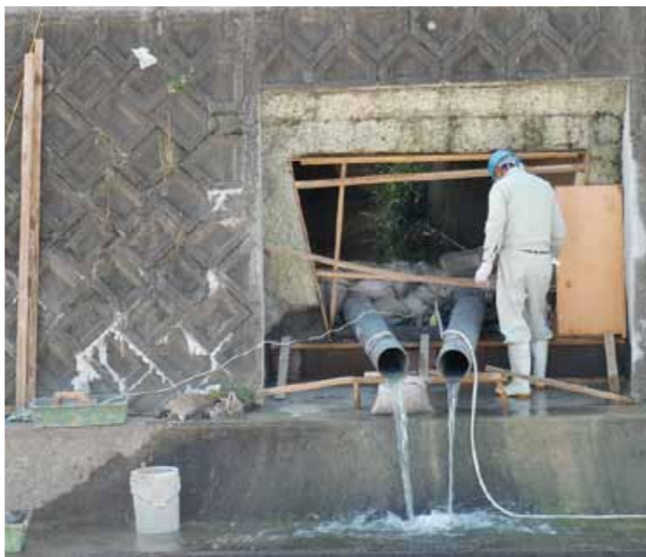
▲久保田橋下流逆流防止工事
