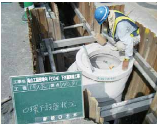
終盤に入った下水道工事
