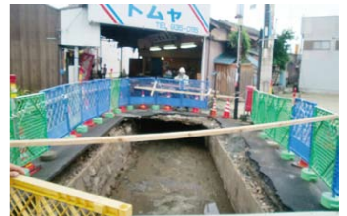
▲老朽化により陥没した水路(東区)
