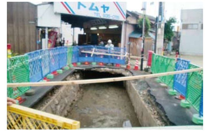
▲老朽化により陥没した水路(東区)
