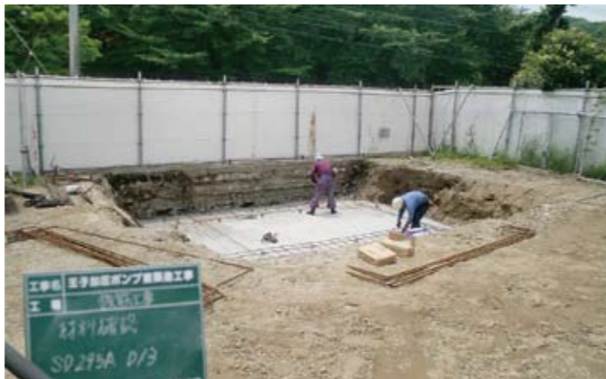
▲王子八幡共同利用施設前にポンプ室設置
