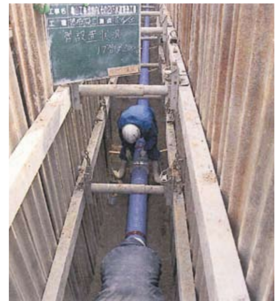
▲下水道工事(亀山工業団地)
