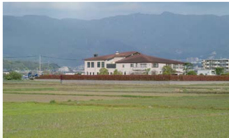
▲浄化センター付近
