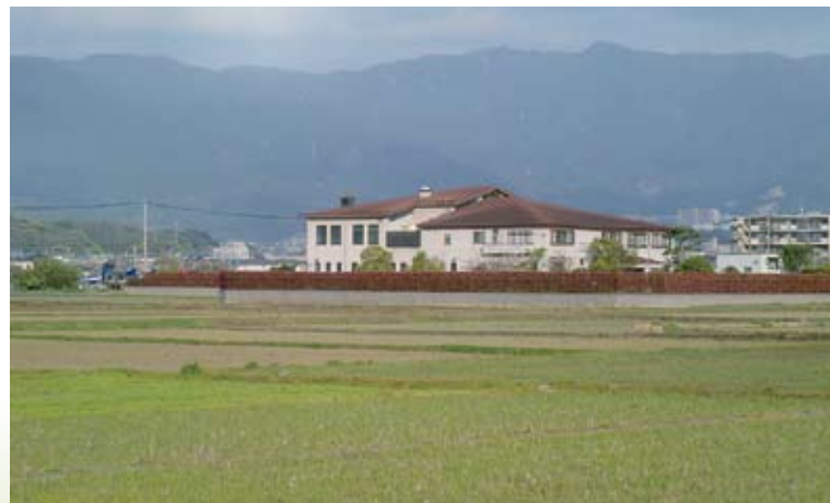
▲浄化センター付近
