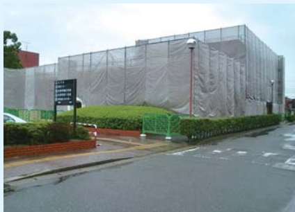
町民センター外部補修工事
