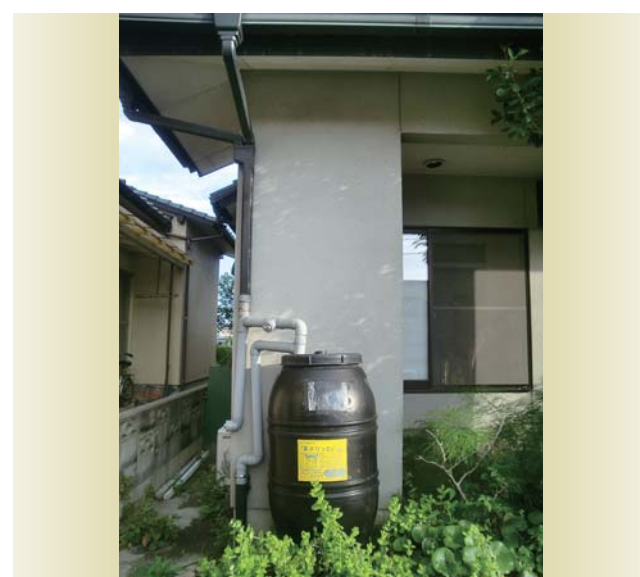
▲雨水タンクの設置
