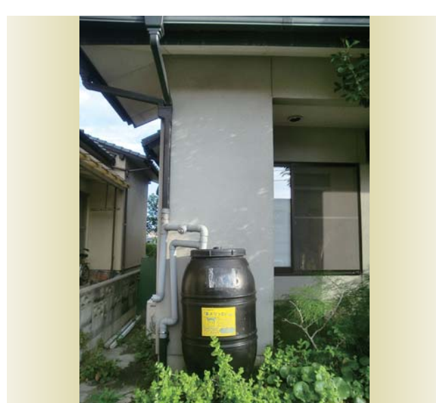
▲雨水タンクの設置
