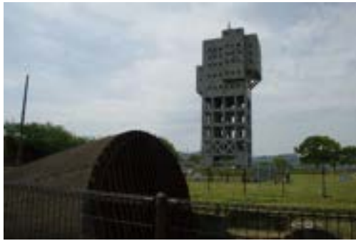
▲旧志免鉱業所 第八坑連卸坑口
