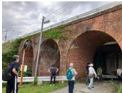
▲旧九州鉄道城山三連橋梁を見学
