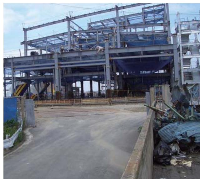
▲建設中のリサイクルセンター
