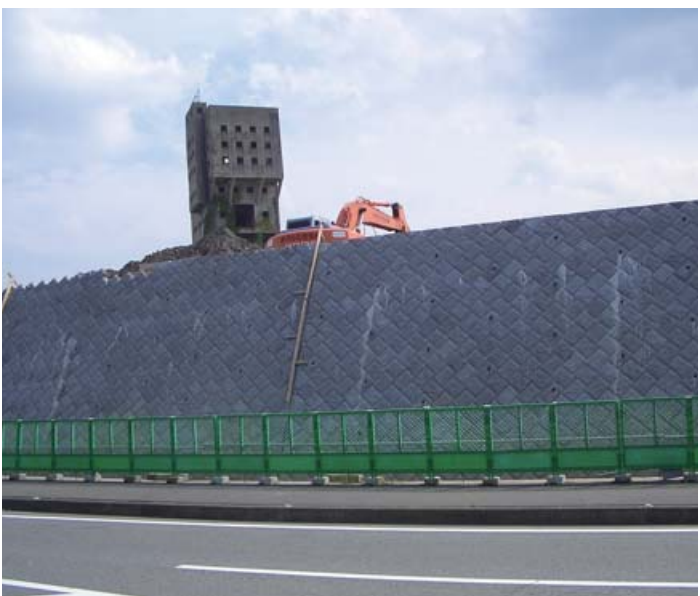
▲炭鉱跡地擁壁工事
