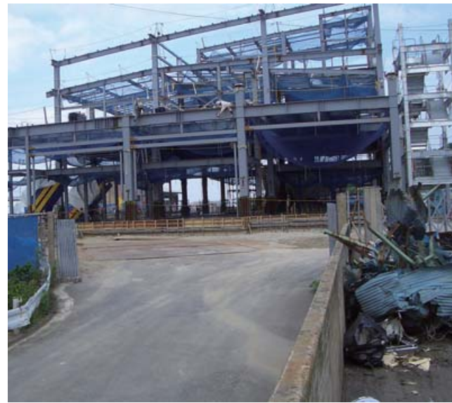
▲建設中のリサイクルセンター
